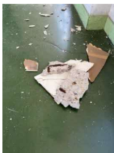
渡り廊下2階天井落下状況
